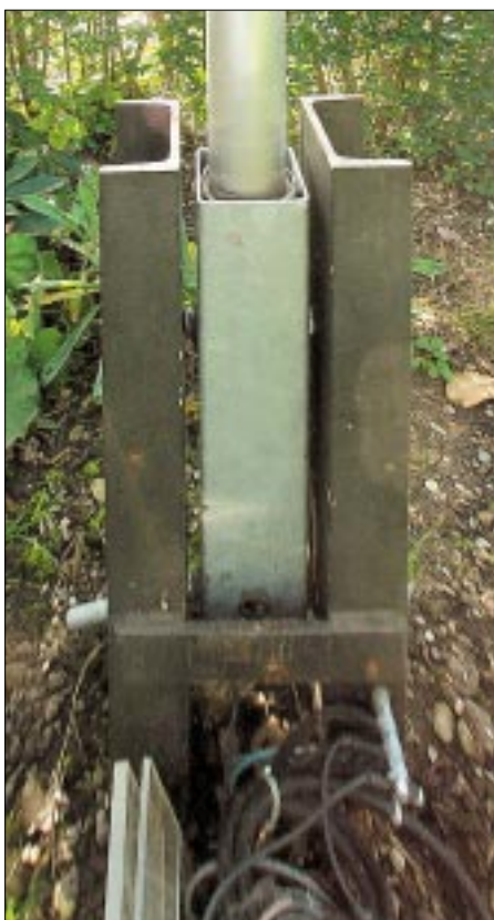
Bild 5: Diese Frontansicht des Mastfußes läßt zugleich den Anschluß der Radials erkennen. Fotos: DL3MCO
